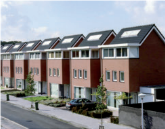
Figuur 4-7 Zonnecollectors geïnstalleerd op het dak van de woning.
