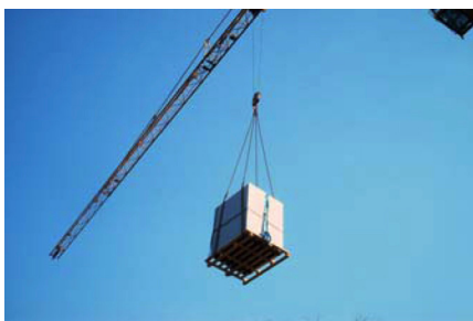
Kraan en bouwlift
